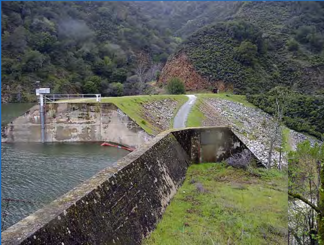
Los Padres Dam – Carmel River
